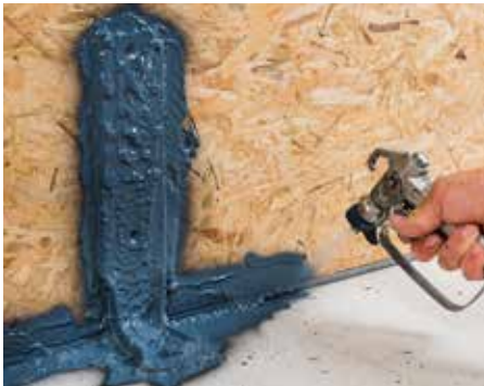
Luftdichtes Übersprühen von Befestigungswinkeln,
