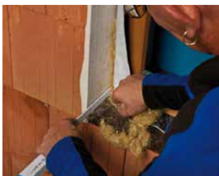
Fenster einsetzen und Fuge dämmen
