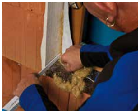
Fenster einsetzen und Fuge dämmen
