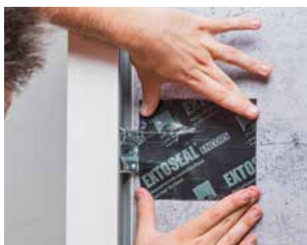
Wasserführende Verklebung von Befestigungswinkeln.
