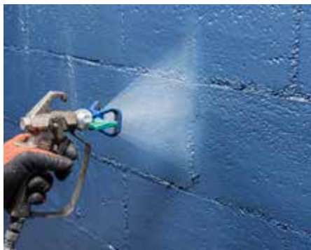
... unverputzten Wänden und
