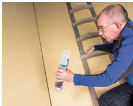
Anwendung auf Holzfaserunterdeckplatten,
