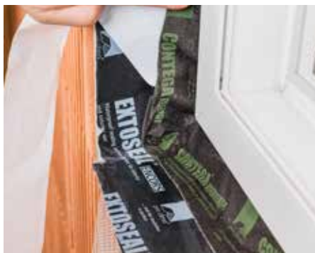
In Ecken luft- bzw. schlagregendicht verkleben.
