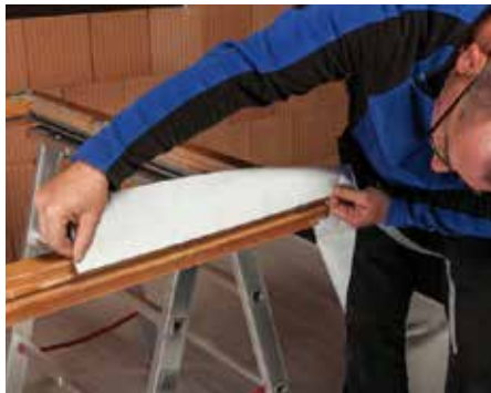
Seitlich am Blendrahmen verkleben
