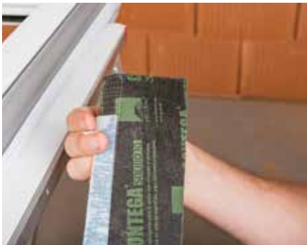
Trennfolienstreifen abziehen.
