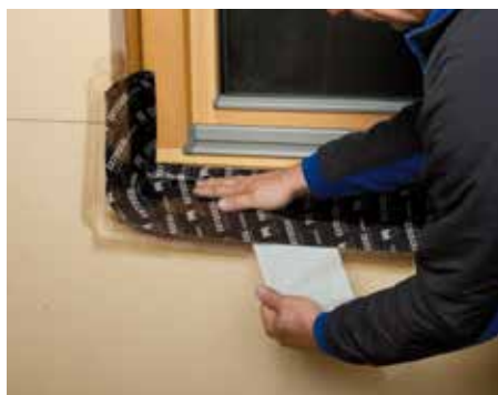
Einsatz als wasserdichte Unterfensterbank.
