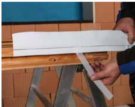
Seitlich am Blendrahmen verkleben
