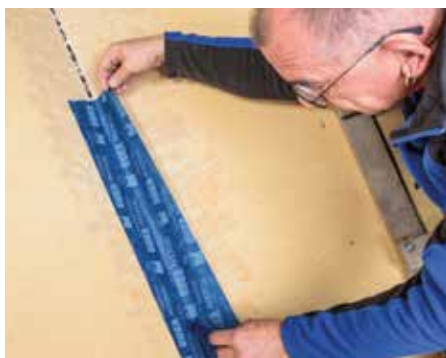
Kleband kann direkt in frischen Primer verklebt werden.
