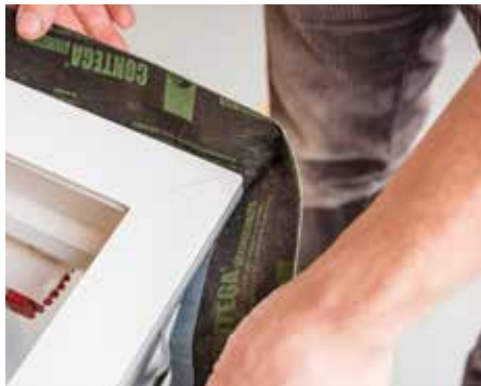
Eckschlaufe herstellen (Länge: 1,5 x Fugenbreite).
