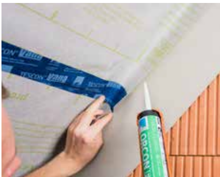
Anschlusskleber für Luftdichtungsbahnen innen,
